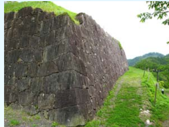
二の丸石垣(南より)
